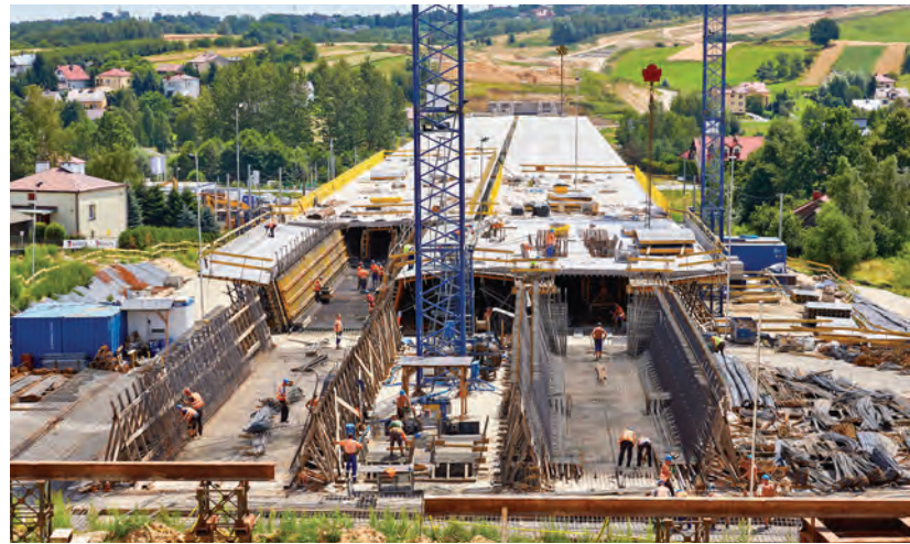
Budowa estakady E-1
