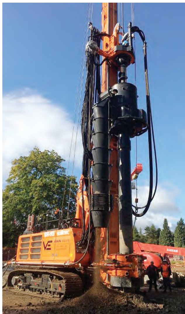
Fot. 3. Palownica z osprzętem CCFA wyposażona w układ odbierający urobek ( www.van-elle.co.uk )
