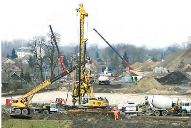
Fot. 1. Wiercenie pali CFA – obiekt (MD-10) w ciągu S7 w Krakowie, fot. Aarsleff Sp. z o.o.
