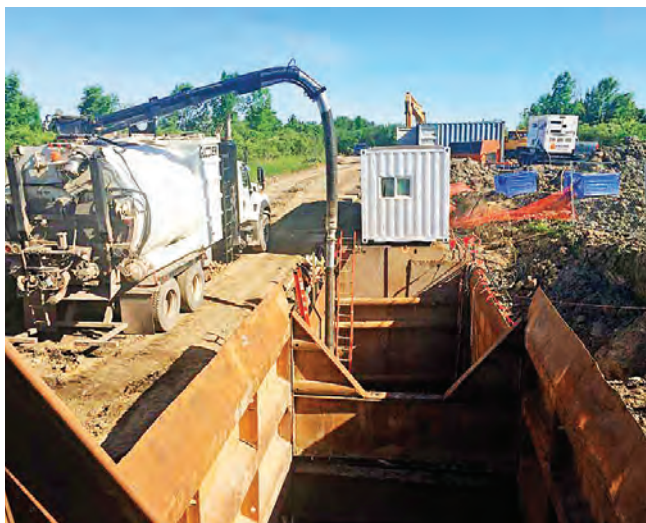
Ryc. 2. Realizacja inwestycji miała bardzo mały wpływ na otoczenie [2]
