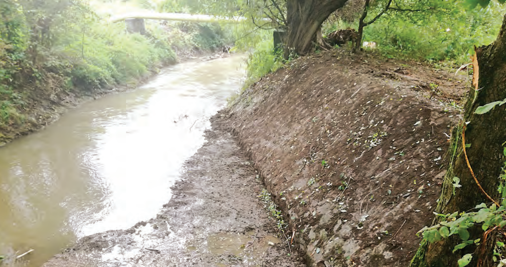
Kanal burzowy na Dłubni przy ul. Ptaszyckiego w Krakowie
