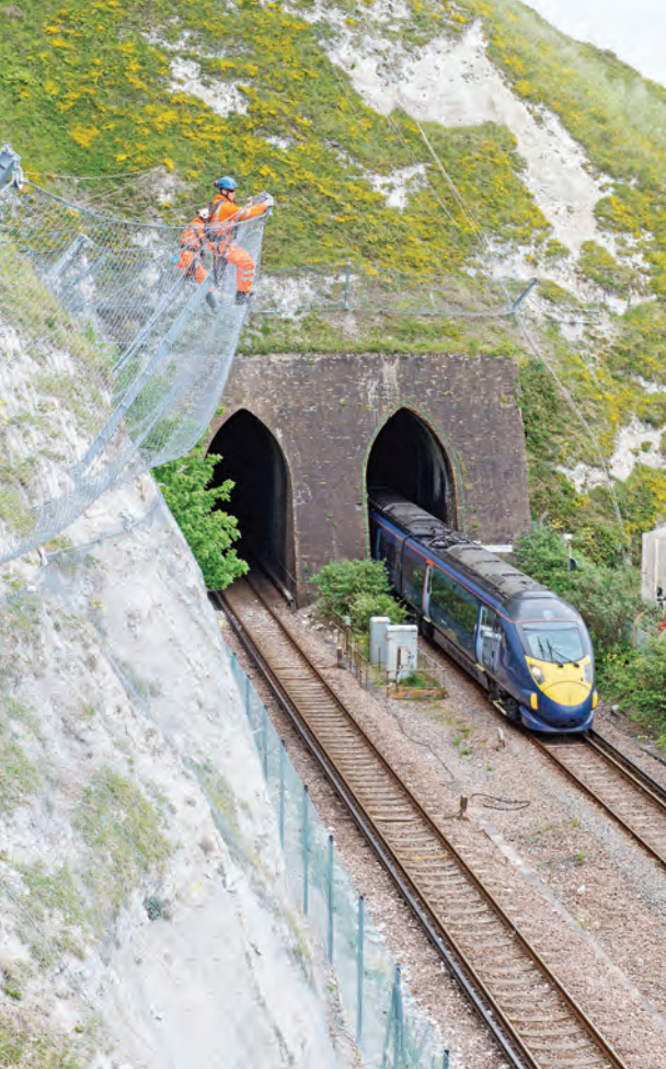
Barierę chroniące przed odłamkami skalnymi wykonane z drutu stalowego o wysokiej wytrzymałości na rozciąganie, przykłady z Europy, fot. Geobrugg AG
