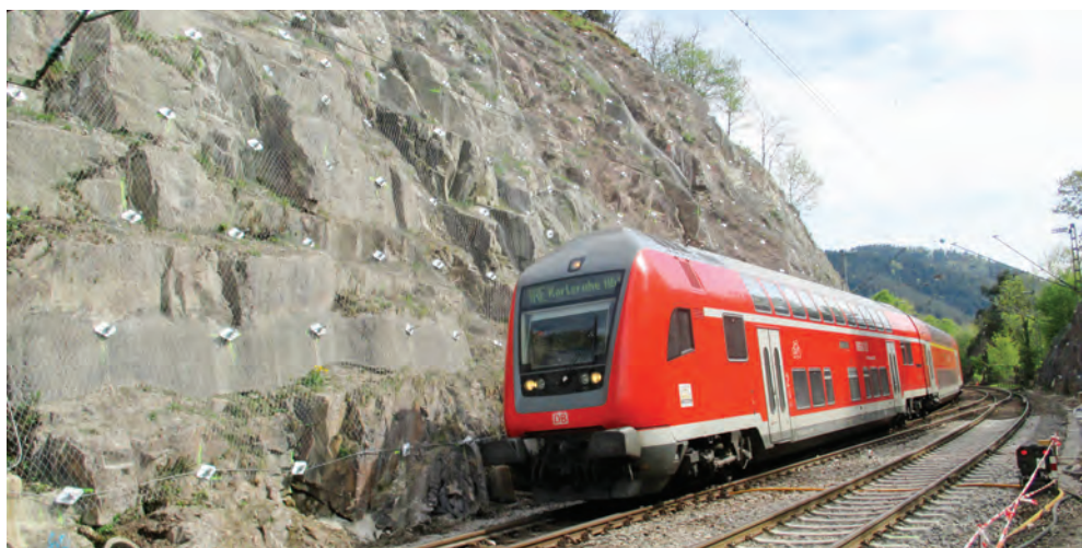
Barierę chroniące przed odłamkami skalnymi wykonane z drutu stalowego o wysokiej wytrzymałości na rozciąganie, przykłady z Europy, fot. Geobrugg AG
