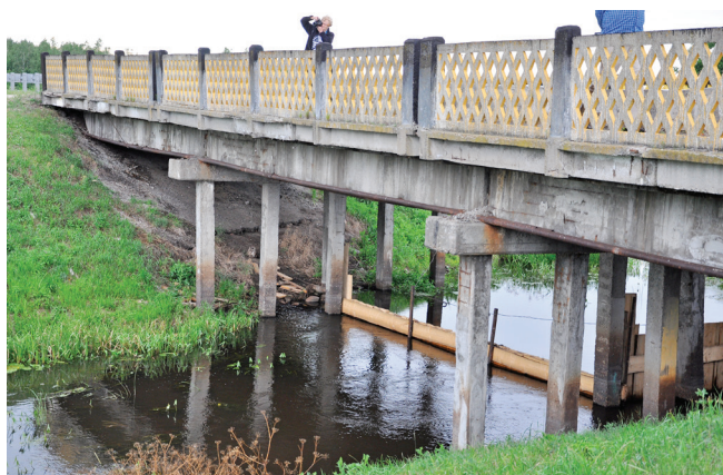
Żelbetonowy most przez Kanał Ogińskiego (obiekt nr 8)
