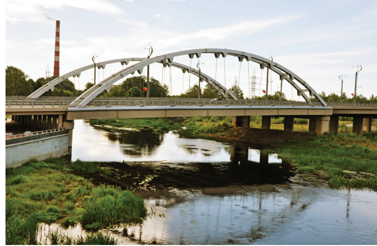
Most łukowy przez Muchawiec w Brześciu (obiekt nr 2)
