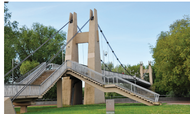
Wisząca kładka dla pieszych przez Muchawiec w Brześciu (obiekt nr 3)
