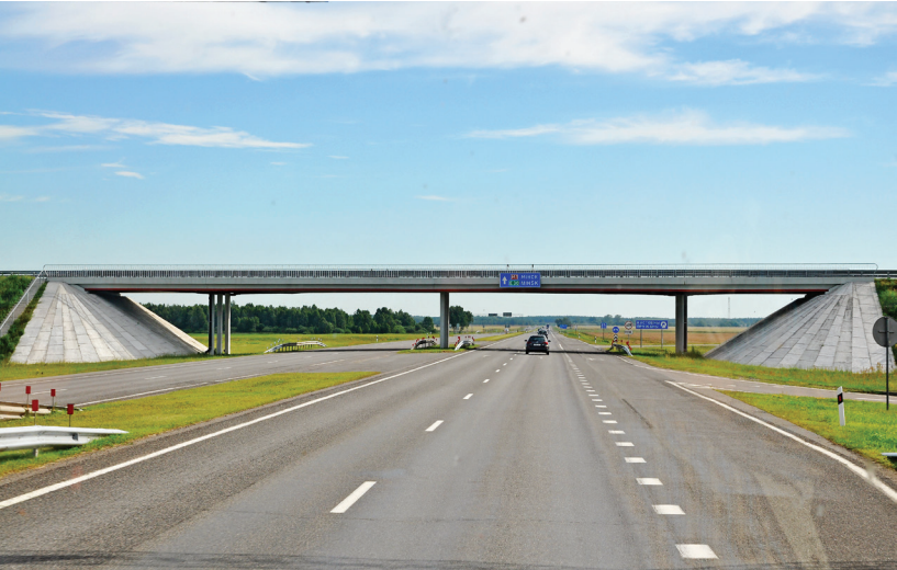
Betonowy wiadukt belkowy nad autostradą Brześć – Mińsk (obiekt nr 4)
