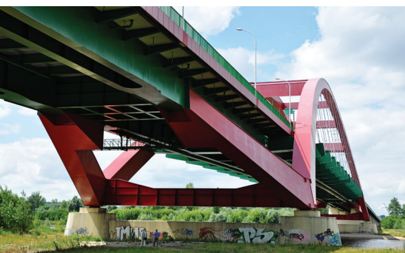
Stalowy most łukowy przez Wisłę w Puławach (obiekt nr 1)
