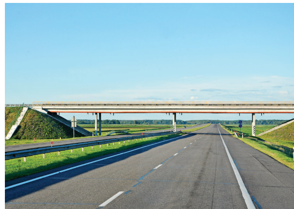
Betonowy wiadukt belkowy nad autostradą Pińsk – Baranowicze (obiekt nr 10)
