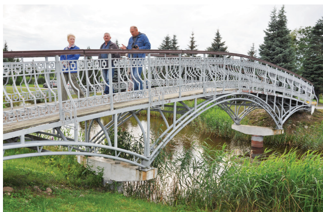
Stalowa, tutowa kładka dla pieszych w okolicy Jeziora Wygonowskiego (obiekt nr 9)
