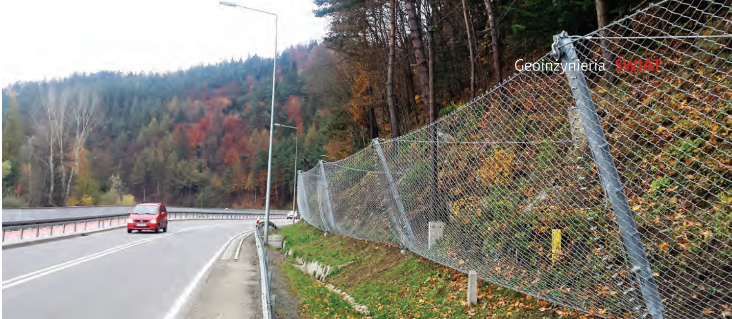
Droga krajowa nr 87, zamontowana bariera typu GBE-500-A
