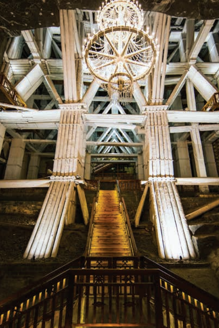
Komora Michałowice na trasie turystycznej. Majestatyczna drewniana obudowa jest dziełem górniczych cieśli i pochodzi z XIX w.
