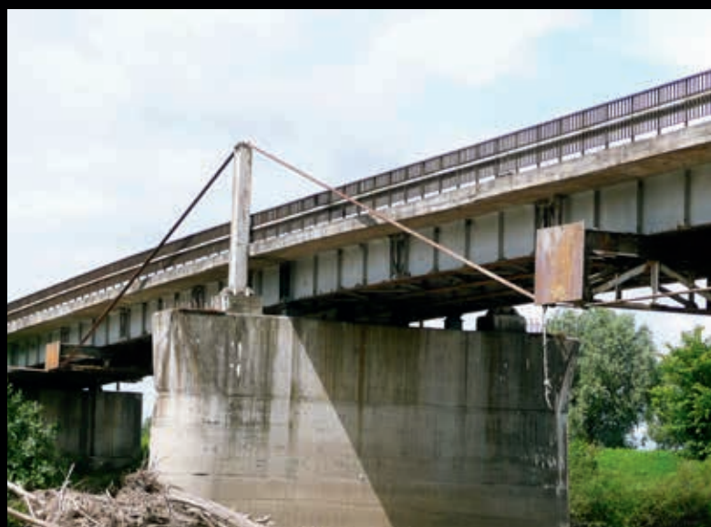
Most przez San w Rzuchowie w powiecie leżajskim. Podwieszenie zaprojektowane i zrealizowane w latach 70. XX w. pod nadzorem Marka Łagody. Był to, w ocenie autora tego tekstu, pierwszy na świecie most typu extradosed – dzieło Marka Łagody
