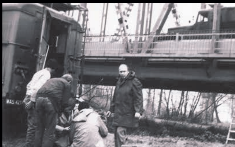
Wspólne badania mostu w Tryńczy przez Wisłok pod próbnym obciążeniem, 1986 r.
