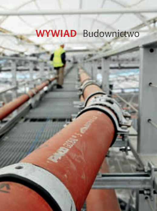
Na Stadionie Narodowym w Warszawie zastosowano system podciśnieniowego odprowadzenia wody z dachu Epams: rury SMU S, złączki Rapid, obejmy pazurowe PAM2, na odpowiednich odcinkach obejmy HP Grip wytrzymujące wysokie ciśnienie
