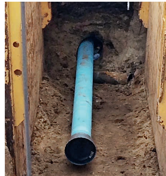
Budowa wodociągu metodą krakingu przy ul. Sienkiewicza w Łodzi w 2017 r. za pomocą rur DN 150 Uni Ve ZMU. Inwestor: ŁSI Łódź, projektant: ŁSI, wykonawca: Zinsbud Inżynieria Bezwykopowa
