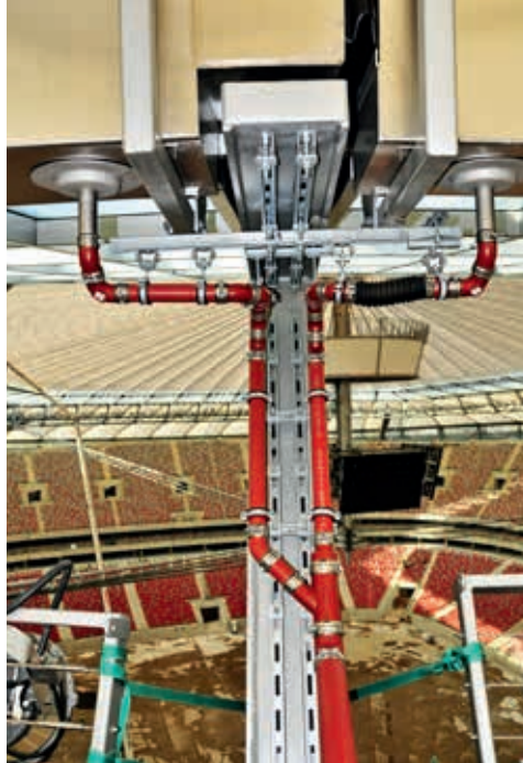
Na Stadionie Narodowym w Warszawie zastosowano system podciśnieniowego odprowadzenia wody z dachu Epams: rury SMU S, złączki Rapid, obejmy pazurowe PAM2, na odpowiednich odcinkach obejmy HP Grip wytrzymujące wysokie ciśnienie
