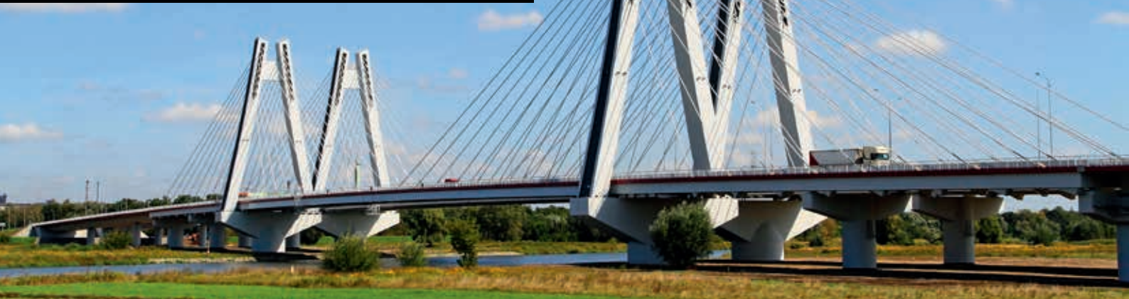
Most drogowy w ciągu drogi ekspresowej S7 przez Wisłę w Krakowie
