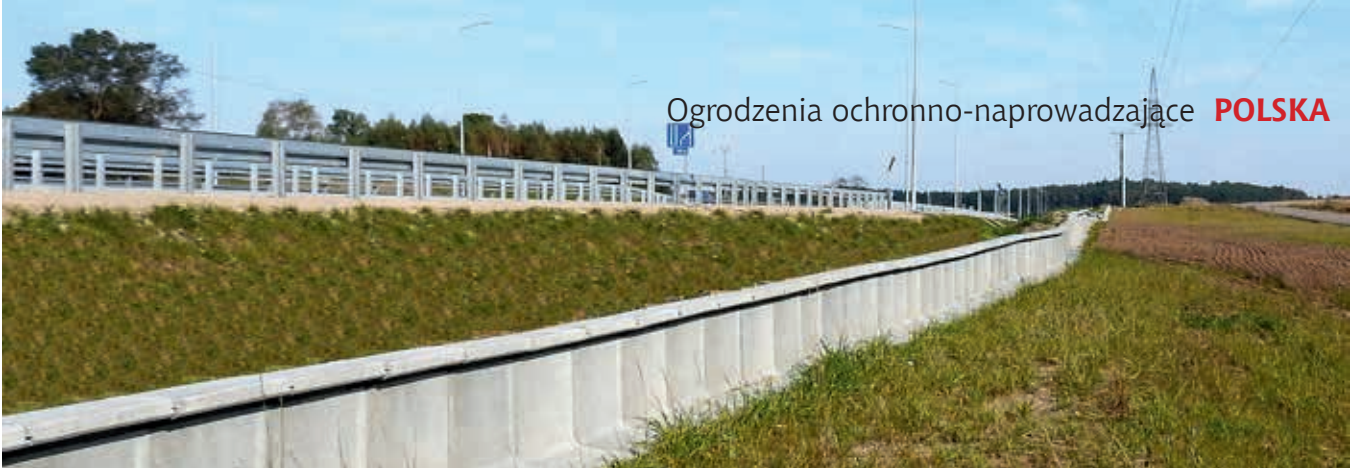
Przykład realizacji systemu optemFROG na DK20, obwodnicy Kościerzyny
