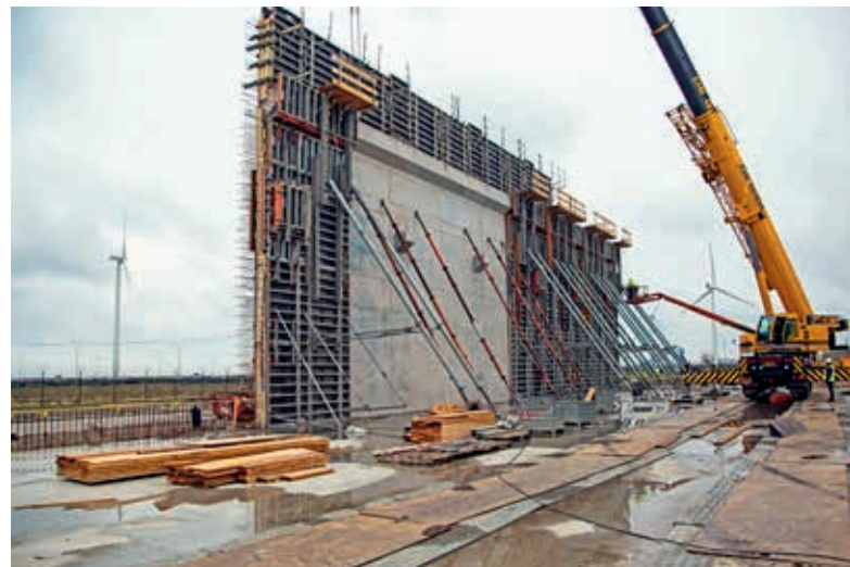
Wsporniki do belki podsusowniczej oraz do prefabrykowanych betonowych belek dachowych wylano razem ze ścianami w jednym takcie
