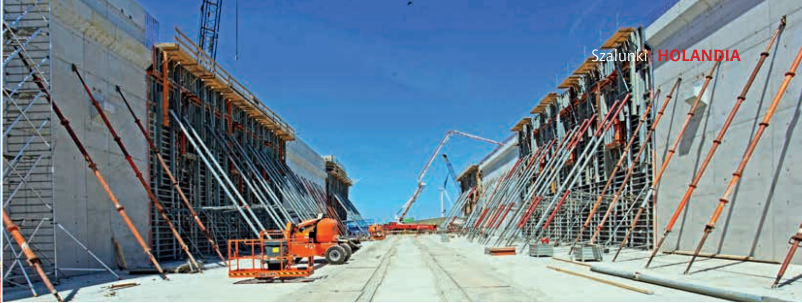
Ogromne panele NOEtop ze zintegrowanymi pasami usztywniającymi sprawiają, że szalunki można szybko postawić, a potem szybko zdjąć
