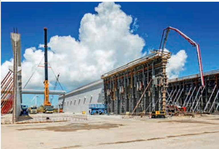
Wsporniki do belki podsusowniczej oraz do prefabrykowanych betonowych belek dachowych wylano razem ze ścianami w jednym takcie
