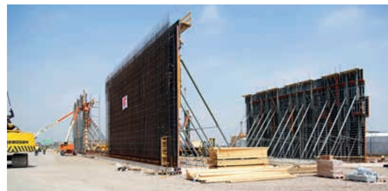
Ściany mają do 13,25 m wysokości i są formowane za pomocą ogromnych paneli NOEtop ze zintegrowanym systemem pasów usztywniających
