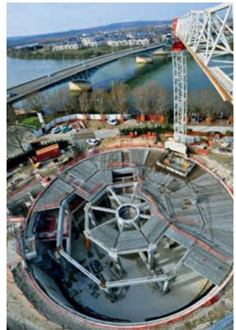
Budowa zlewni burzowej Joffre
