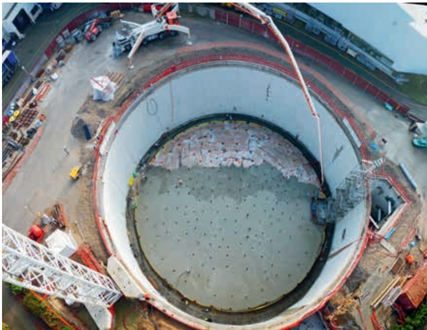
Budowa zbiornika magazynowego Poissy Bridge o pojemności 8100 m 3
