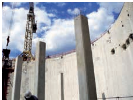
Zbiornik Mont Valérien: 21 000 m 3 objętości, średnica 45 m, głębokość 15 m – magazynowanie czystej wody
