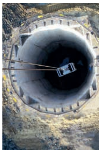
Elektrownia Opole – zbiorniki retencyjne o wymiarach 11 x 52 m, głębokość 8,85 m
