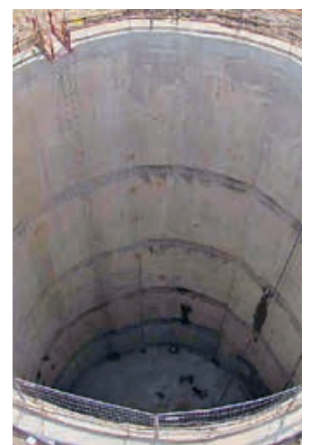
Płock – zbiornik spiralny, średnica 15,8 m, głębokość 31,6 m
