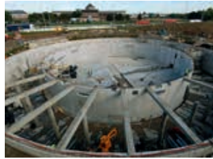
Budowa zlewni burzowej Joffre
