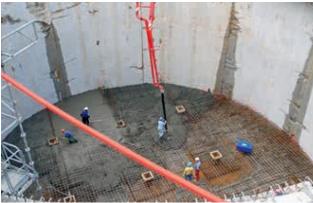
Zbiornik Le Havre: 3500 m 3 objętości, średnica 22 m, głębokość 20 m, system rurowy – sptukiwanie jako system oczyszczania
