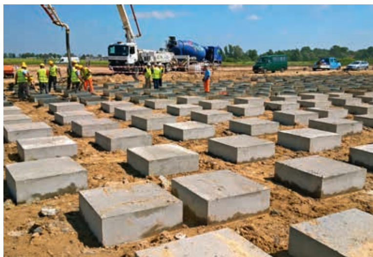
Betonowanie czapek na głowicach pali przemieszczeniowych SDP, fot. Keller Polska
