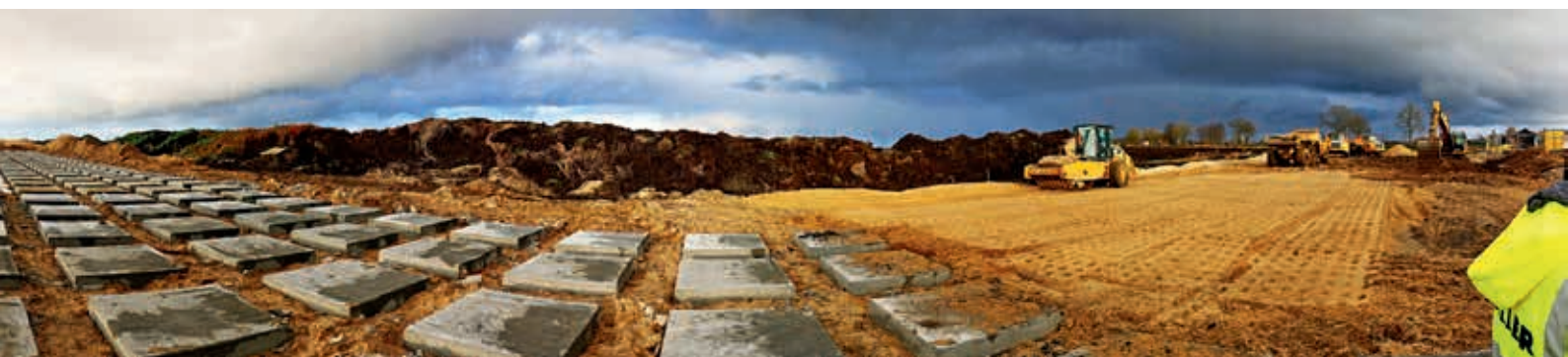
Zabetonowane czapki na głowicach pali przemieszczeniowych SDP, fot. Keller Polska
