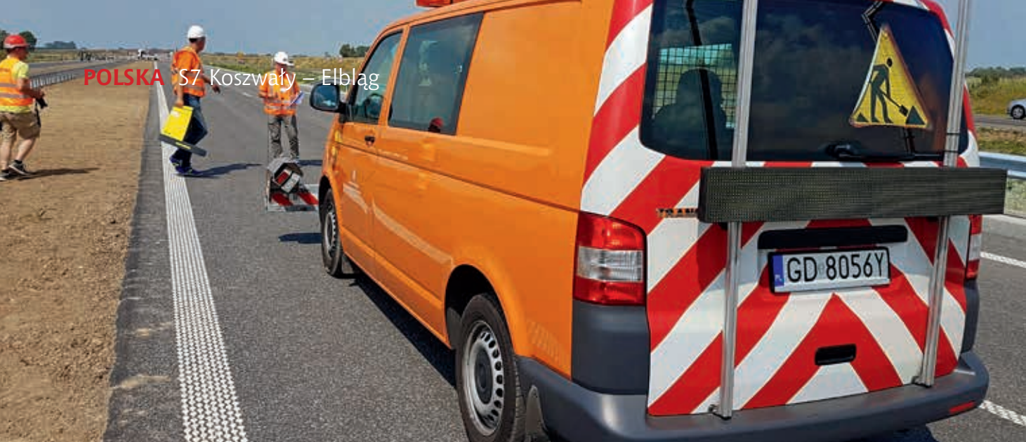
Zadanie 2. Nowy Dwór Gdański – Kazimierzowo, fot. GDDKiA
