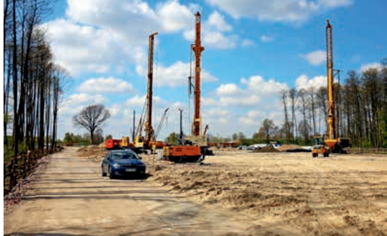
Wykonawstwo kolumn KSS i FSS, fot. Keller Polska
