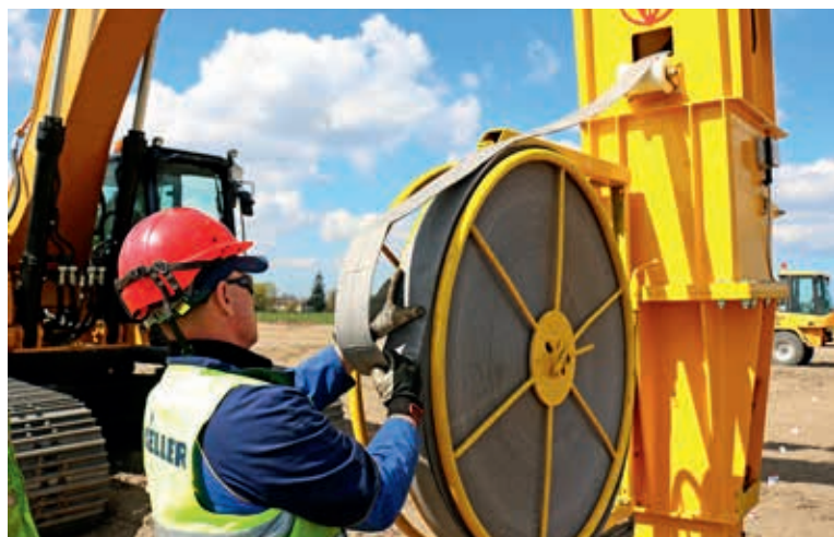
Zakładanie drenu prefabrykowanego na maszynę, fot. Keller Polska
