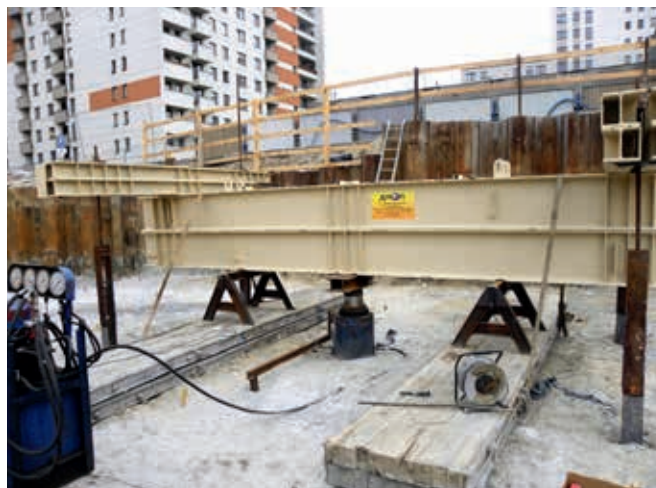
Ryc. 4. Próbné obciążenie kolumny
