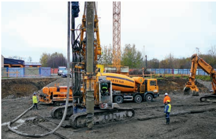
Ryc. 1. Wykonanie pali przemieszczeniowych EGP – plac budowy
