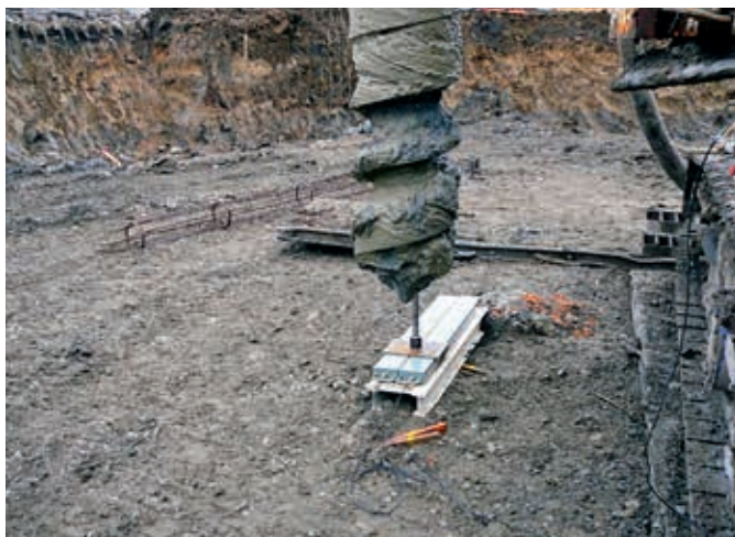
Ryc. 3. Kalibracja sondy statycznej w warunkach budowy
