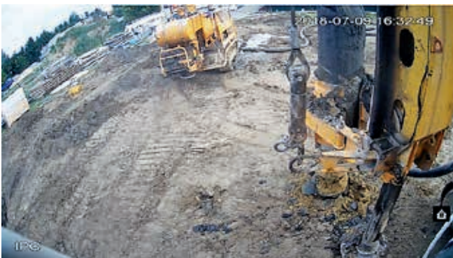
Ryc. 7. Widok z kabiny operatora maszyny
