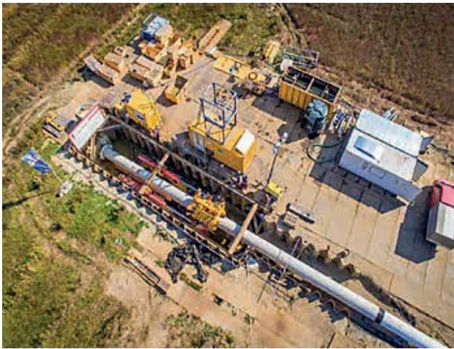
Ryc. 13. Plac budowy gazociągu Czeszów – Wierzchowice
