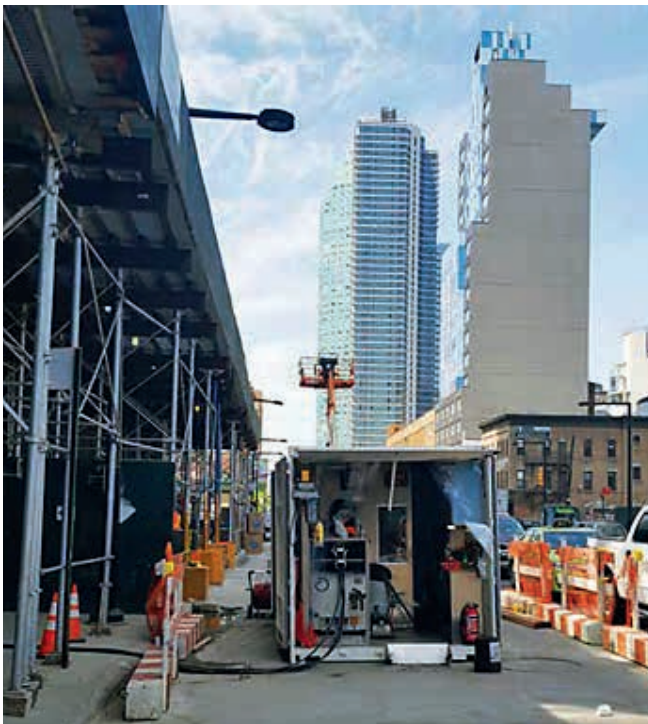
Ryc. 8. Kontener ProKASRO w miejscu naprawy kolektora kanalizacyjnego w Nowym Jorku
