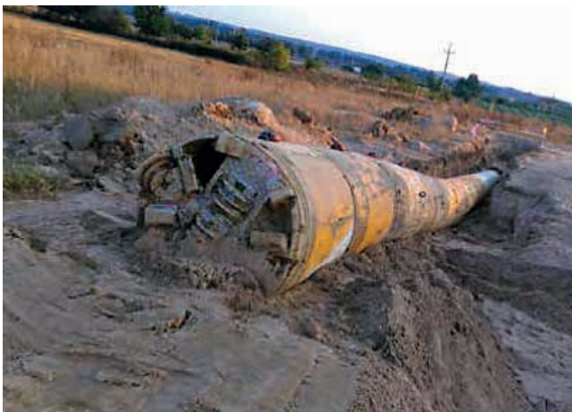
Ryc. 14. Wbudowywanie rur za pomocą technologii Direct Pipe
