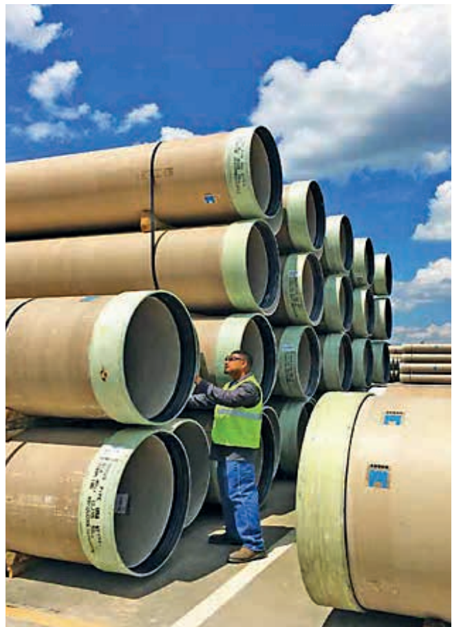
Ryc. 10. Rury Hobas na placu budowy
