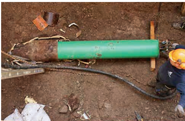
Ryc. 5. Wprowadzenie przewodu z polipropylenu PP-HM do istniejącej konstrukcji wykonanej z kamionki
