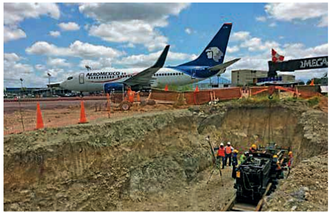
Ryc. 3. Przekład hydrauliczny pod lotniskiem w Monterrey
