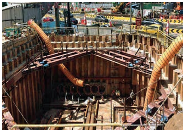
Ryc. 11. Wykop początkowy z zastosowaniem technologii Shuttlemole
