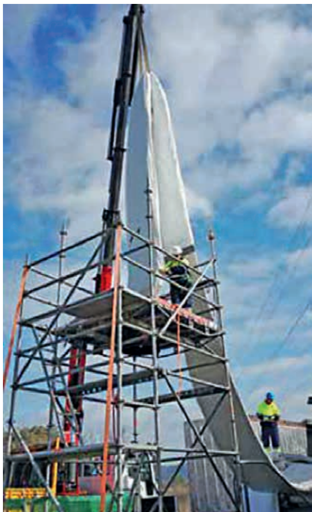
Ryc. 6. Instalowanie rękawa InsituMain® CIPP podczas rehabilitacji magistrali wodociągowej w Kordobie w Hiszpanii
