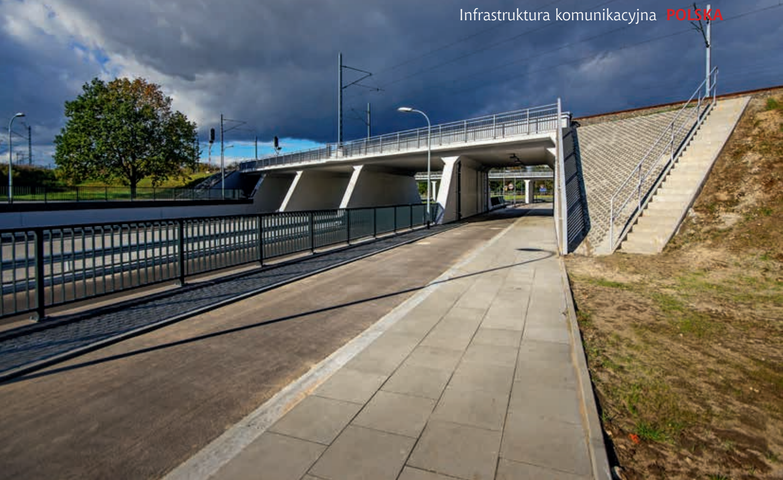
Tunel TK2 – gotowy obiekt
