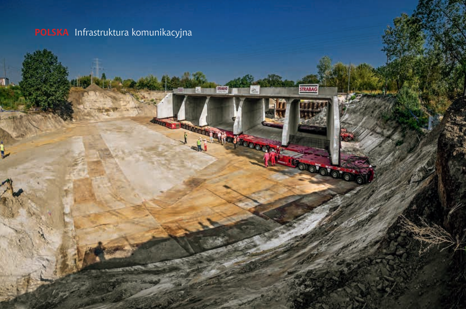
Tunel TK2 oparty na wózkach SPMT i transportowany w miejsce docelowe
