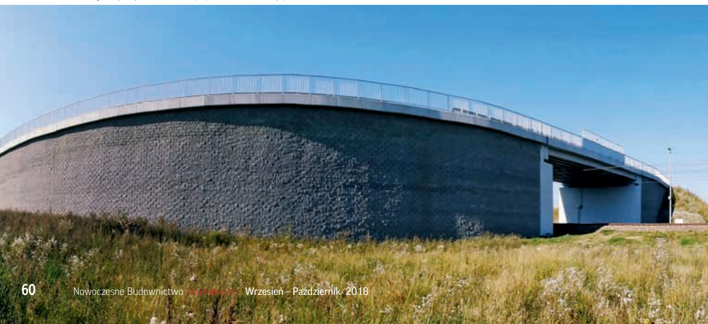
Długie dojazdy do wiaduktów poprowadzone zostały po łuku
