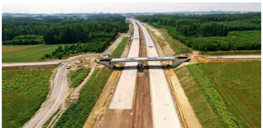
Budowa betonowej autostrady A1, odcinek Zawodzie – Woźniki, fot GDDKiA Oddział w Katowicach
