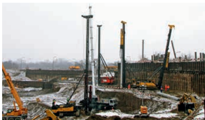
Stadion Narodowy w Warszawie w trakcie wykonywania posadowienia trybun
