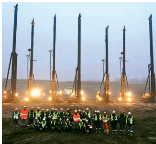
Zakończenie budowy na Stadionie Narodowym w Warszawie
