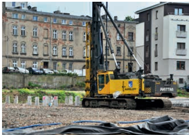
Instalacja pali w trakcie budowy obiektu wielorodzinnego w Gnieźnie
