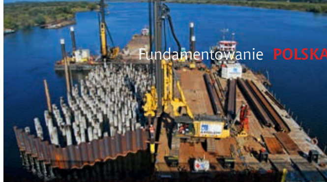
Instalacja pali z jednostek pływających
