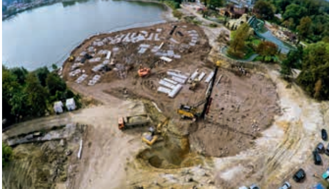
Instalacja pali na budowie rollercoastera, widok z drona
