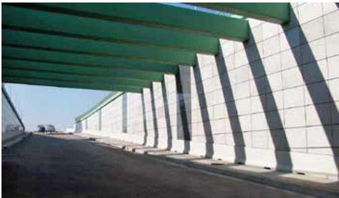
Przykładowa realizacja przejazdu drogowego, archiwium Soletanche Polska
