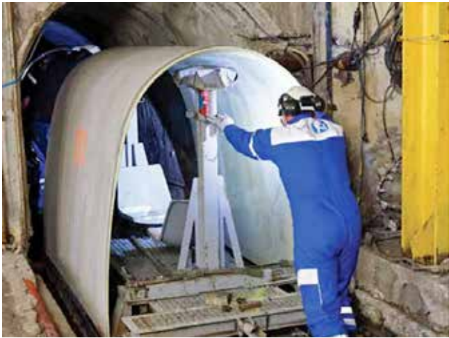
Ryc. 2. Wprowadzanie paneli GRP do kanału [8]
