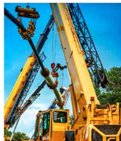
Ryc. 1. Konstrukcje wsporcze w czasie wciągania przewodu [8]
