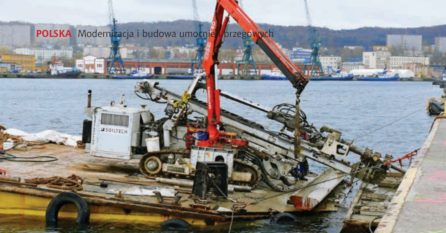
Instalacja mikropali kotwiących – przebudowa Nabrzeża Indyjskiego w porcie Gdynia, fot. Titan Polska Sp. z o.o.
