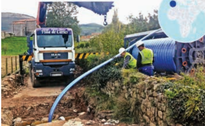
Ryc. 3. Montaż przewodów Primus Liner w Hiszpanii [4]
