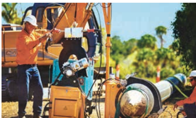
Ryc. 1. Proces spawania ciągu rur z PE 100 w Queensland w Australii [2]
