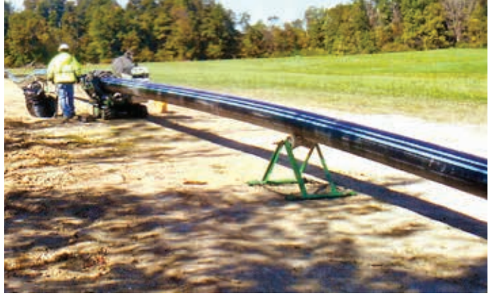
Ryc. 7. Przewody PE-HD na placu budowy w stanie Indiana w USA [1]
