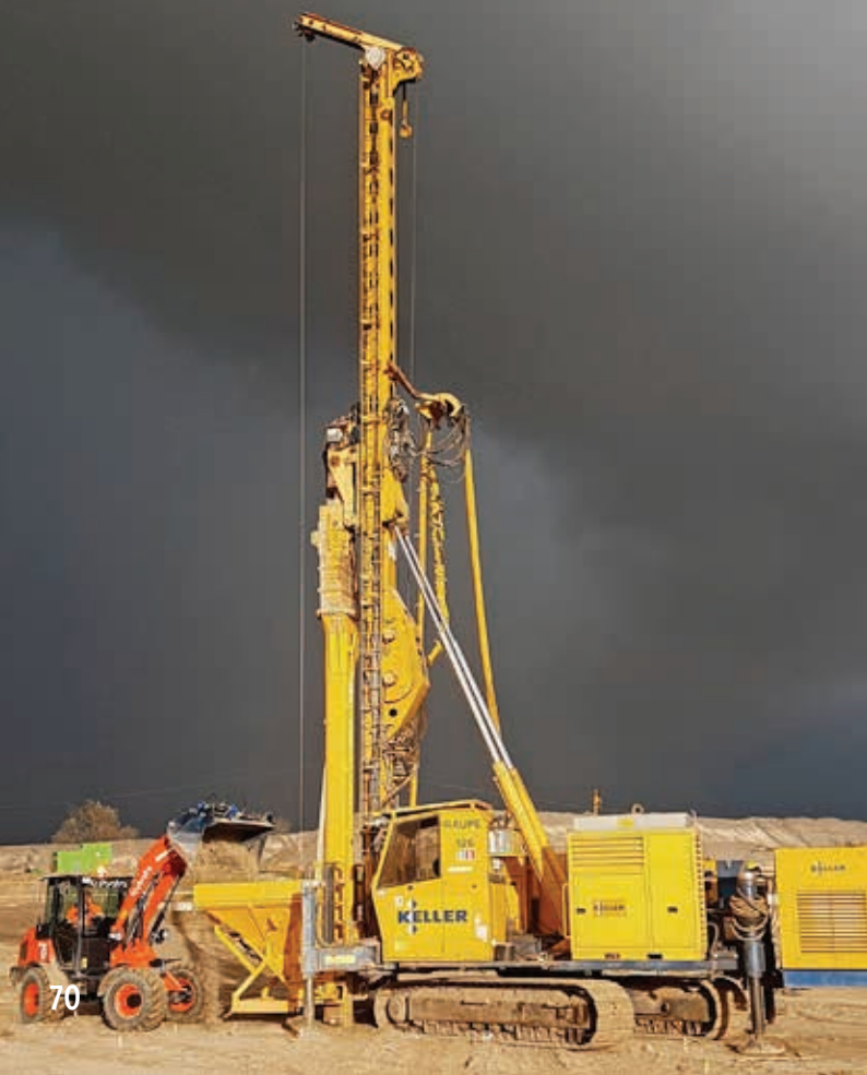
Wykonywanie kolumn KSS metodą wibrowymiany, fot. Keller Polska Sp. z o.o.
