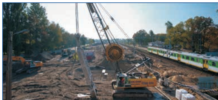
Przejście podziemne na stacji Mława
