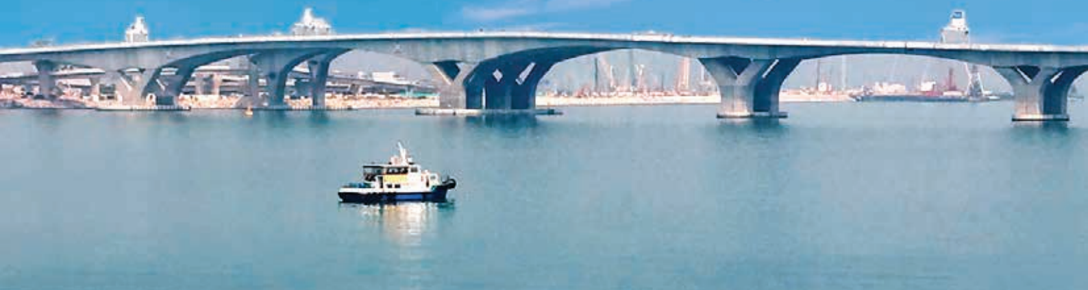
Estakada prowadząca do mostu, fot. Krzysztof Dąbrowiecki
