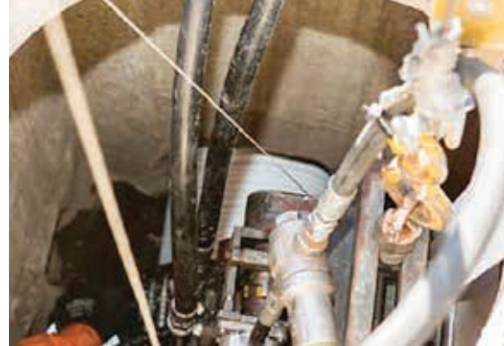
Ryc. 11. Profil SRP EXP zainstalowany w przewodzie
