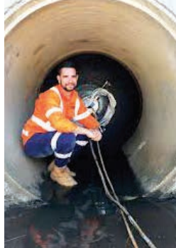
Ryc. 13. Pracownik firmy ITS PipeTech we wnętrzu odnowionego przewodu
