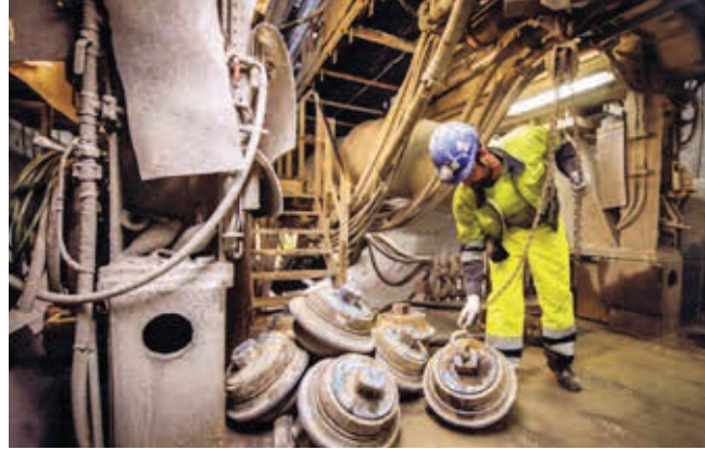
Ryc. 3. Widok wnętrza tunelu. Miejsce pracy pracownika w norweskim tunelu
