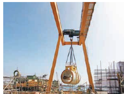
Ryc. 8. Transport przewodu podczas realizacji w Chile
