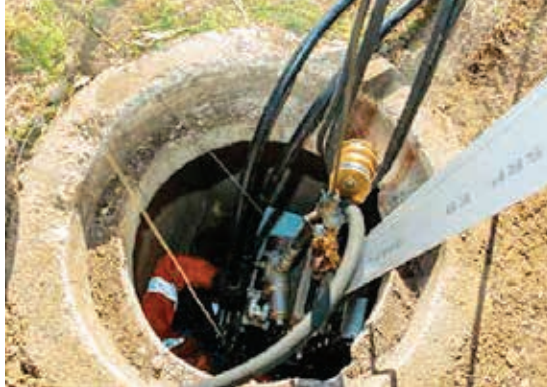
Ryc. 10. Profil SRP EXP nawinięty na otwór
