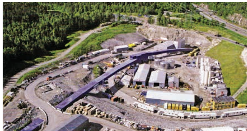
Ryc. 4. Widok centralnego placu budowy z lotu ptaka – projekt Follo Line w Norwegii
