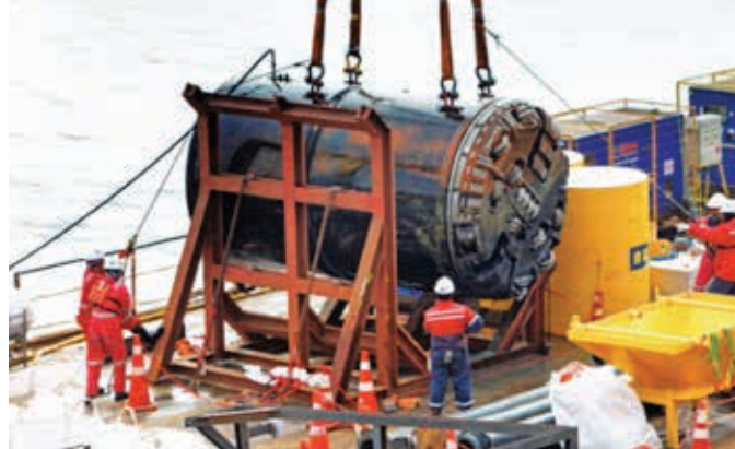
Ryc. 7. Głowica MTBM na pokładzie barki wiertniczej
