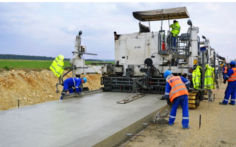
Budowa obwodnicy Malni i Choruli
