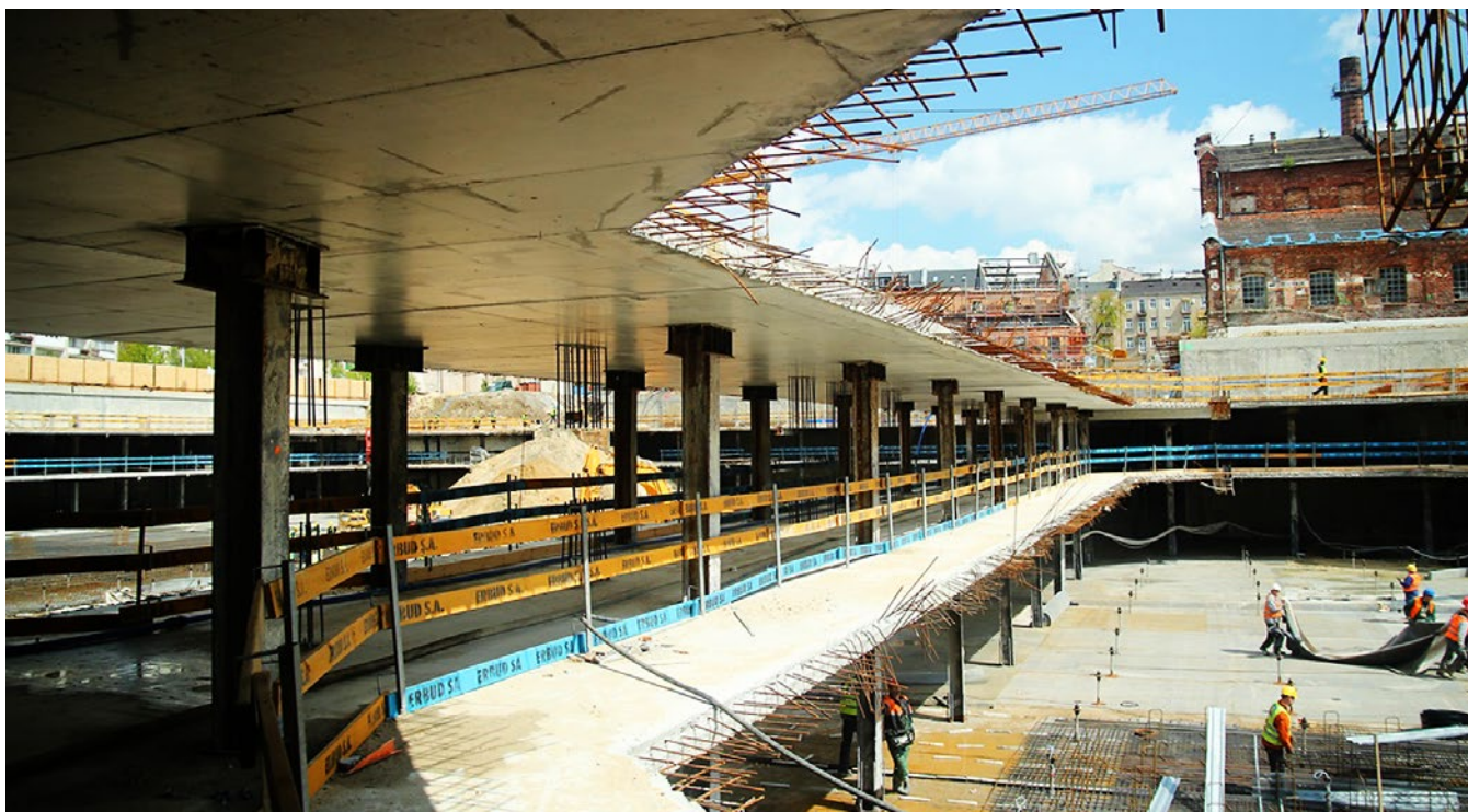
Wykonanie podbicia metodą jet grouting, Centrum Praskie Koneser, fot. Soletanche Polska Sp. z o.o.
