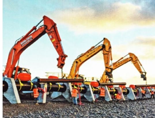
Ryc. 5. Rurociąg przygotowany na powierzchni terenu, gotowy do przetransportowania i wbudowania [3]
