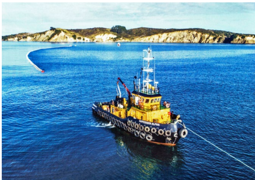
Ryc. 6. Holowanie rurociągu z Kaiaua do Army Bay [3]
