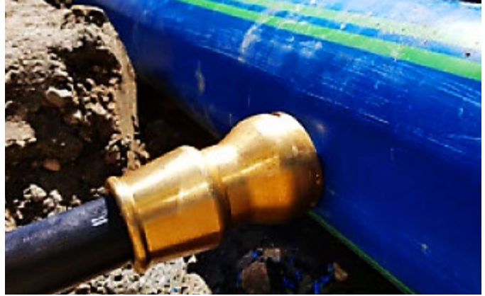
Ryc. 3. Włączenie przyłącza do wodociągu wykonane za pomocą urządzenia Hawle NoDig System [7]
