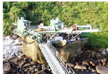
Ryc. 1. Wykop startowy (punkt wejścia) na wyspie Sha Chau [3]
