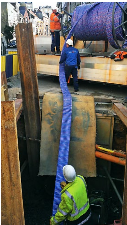
Ryc. 8. Instalowanie powłoki Primus Line w przewodzie wodociągowym DN 350 w Brukseli [5]
