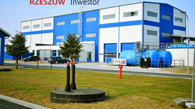
Suszarnia Mechaniczna Osadów Ściekowych
