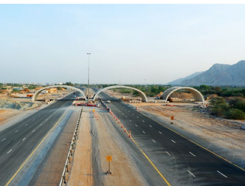
Ryc. 3. Montaż powłok stalowych
