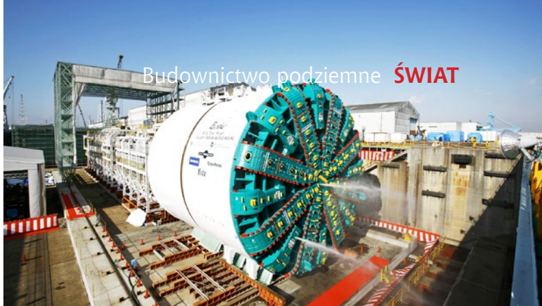
Ryc. 11. Maszyna TBM EPB o średnicy 17,4 m – widok w szybie startowym przed rozpoczęciem drążenia tunelu Alaskan Way, fot. z archiwum A. Siemińskiej-Lewandowskiej
