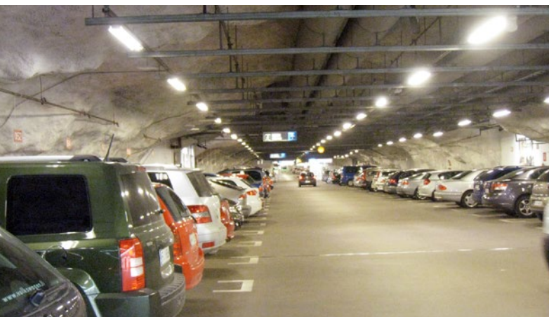
Ryc. 16. Podziemny parking w Helsinkach, fot. A. Siemińska-Lewandowska
