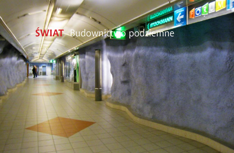
Ryc. 15. Przejście podziemne dla pieszych w kierunku centrum handlowego w Helsinkach, fot. A. Siemińska-Lewandowska
