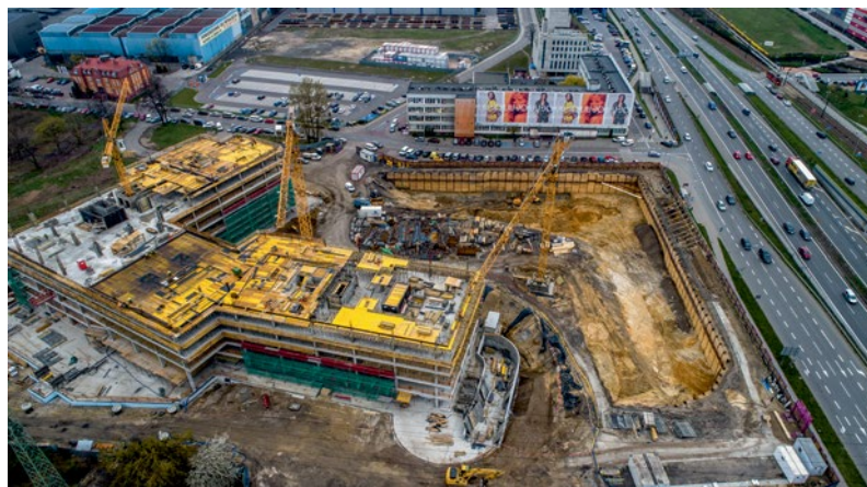
Ścianka pograżana bezwibracyjnie w pobliżu zabytkowej piekarni Mamut we Wrocławiu
