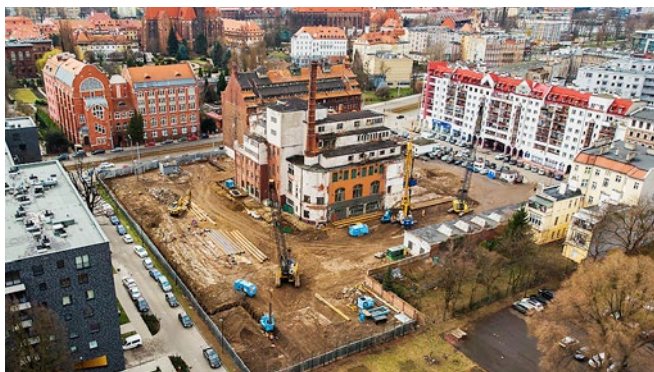
Ścianka pograżana bezwibracyjnie w pobliżu zabytkowej piekarni Mamut we Wrocławiu
