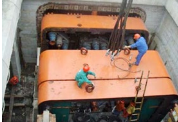
Ryc. 14. Montaż prostokątnego urządzenia tarczowego [26]
