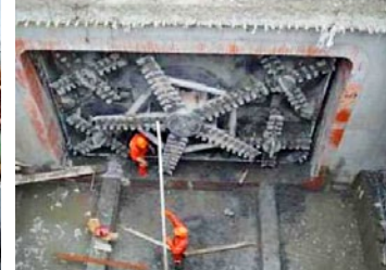
Ryc. 17. Wyjście prostokątnego urządzenia tarczowego do wykopu końcowego [26]
