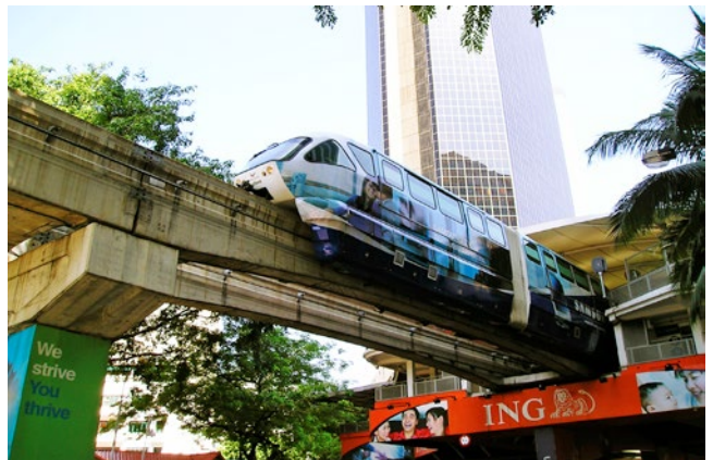
Ryc. 29. Fragment konstrukcji napowietrznej linii metra w Kuala Lumpur, fot. A. Kuliczkowski
