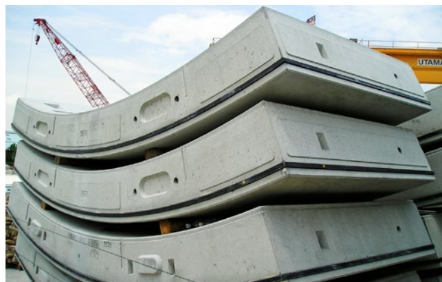
Ryc. 23. Żelbetowe tubingi z uszczelkami, fot. A. Kulickowski
