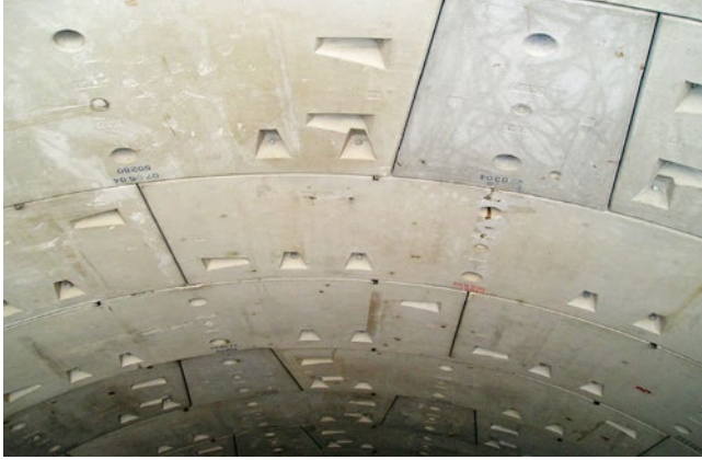
Ryc. 24. Zmontowane tubingi żelbetowe, fot. A. Kuliczkowski
