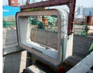
Ryc. 16. Opuszczanie prefabrykatu żelbetowego na dno wykopu początkowego [26]
