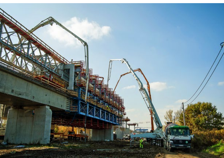
Na stronie most Południowy w Warszawie, fot. K. Nalewajko GDDKiA
