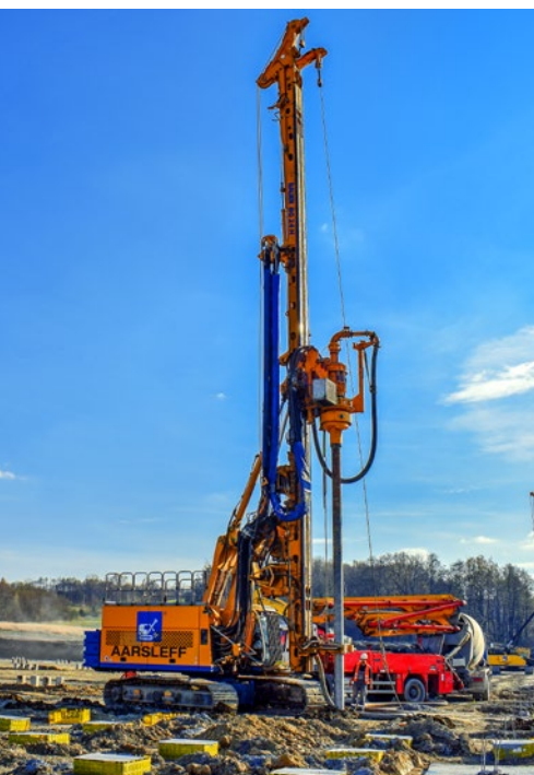
Wykonywanie pali FDP
