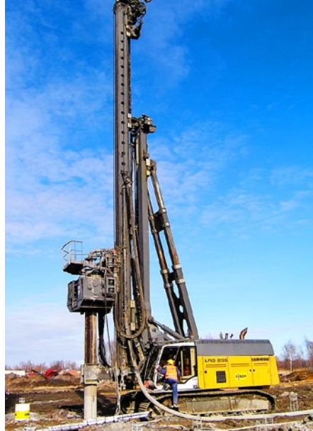
Pale VDP wykonywane wibromłotem przelotowym
