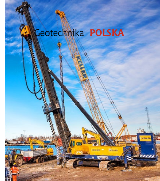
Nachylone pale CFA wykonywane maszyną Fundex F3500
