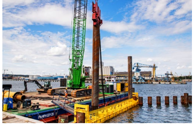
Wwibrowywanie pali rurowych pod konstrukcję nabrzeża portowego
