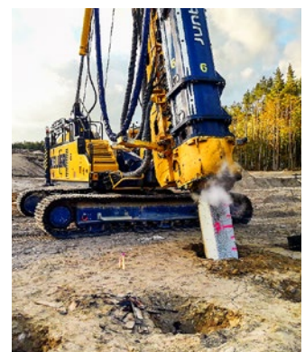
Wbijanie nachylonych pali prefabrykowanych
