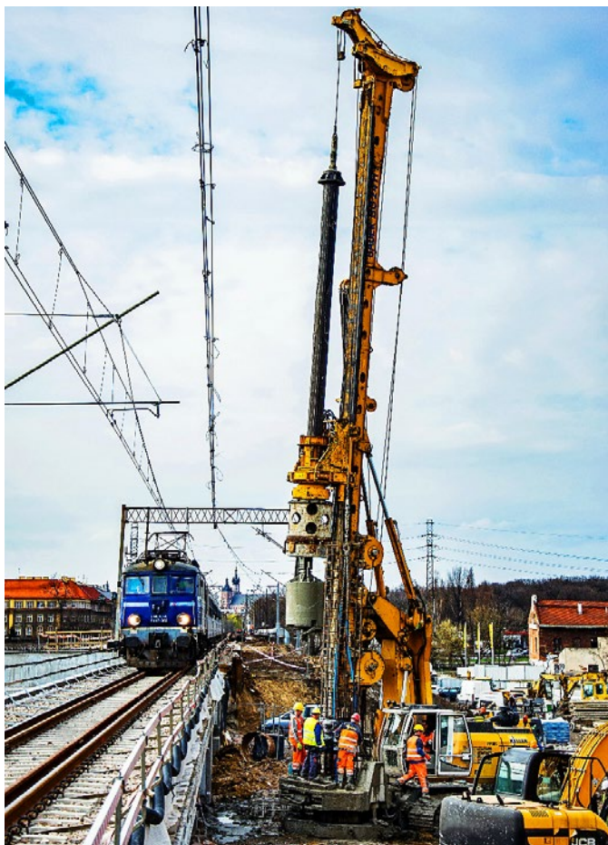
Wykonanie pali wierconych w pobliżu czynnej linii kolejowej
