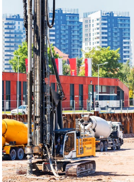
Pale SDP wykonywane maszyną Liebherr LB24
