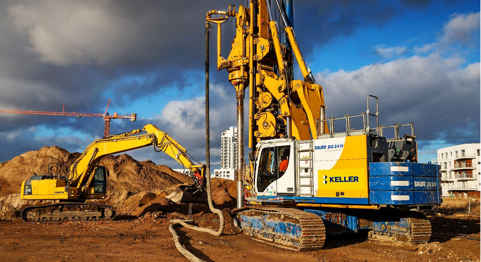
Wykonawstwo pali SDP maszyną Bauer BG24H
