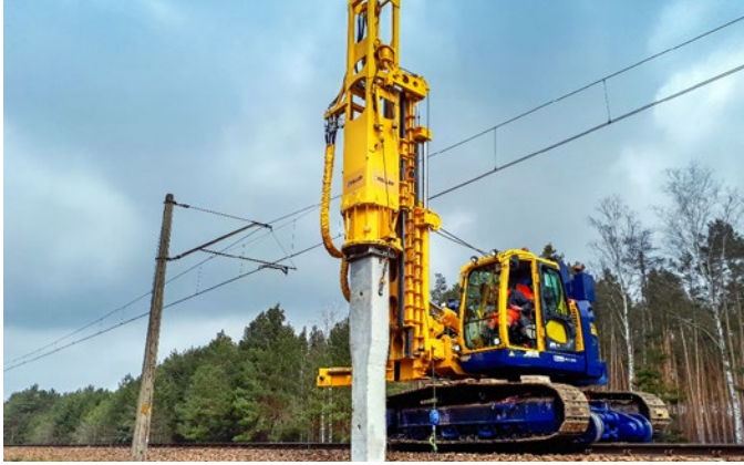
Pale prefabrykowane wykonywane maszyną z podwoziem szynowym
