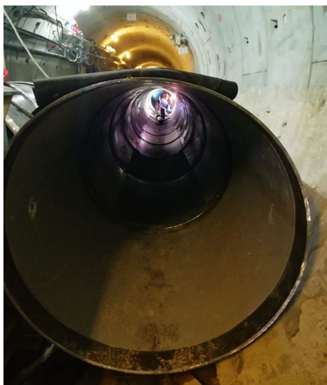
Montaż rurociągów stalowych
