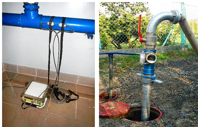
Test hydrantowy w ramach kampanii pomiarowej wodociągowej
