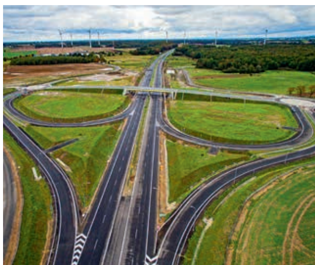
S6, Kołobrzeg – Ustronie Morskie, obwodnica Koszalina i Sianowa, fot. PORR SA
