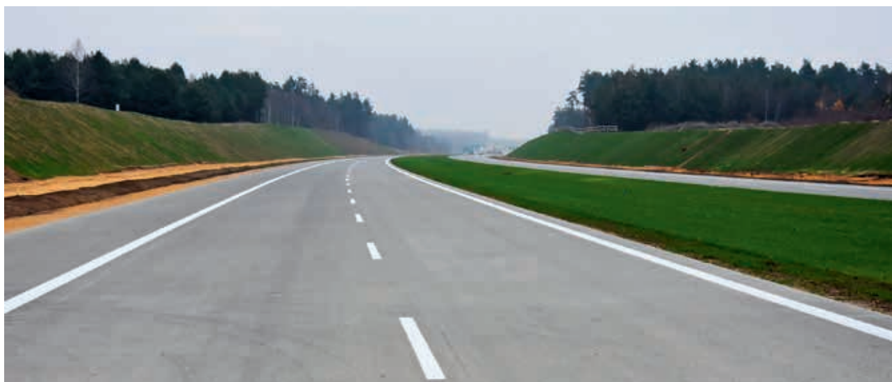
Autostrada A1, obwodnica Częstochowy z nawierzchnią betonową, oddana do użytku w grudniu 2019 r., fot. SPC
