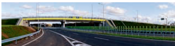
S6, Kołobrzeg – Ustronie Morskie, obwodnica Koszalina i Sianowa, fot. PORR SA
