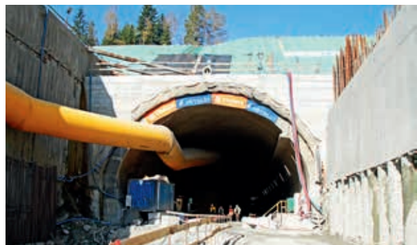
Budowa tunelu na S7, Skomielna Biała – Rabka-Zdrój, fot. nbi medla
