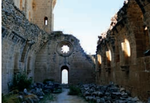
Klasztor Augustianów, wewnątrz mieszkalne pod dachem nieba
