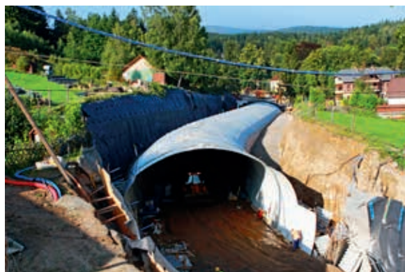
Zabezpieczenie ścian wykopu przy budowie tunelu w Karpaczu
