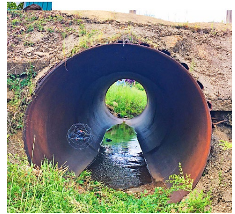
Ryc. 8. Pokaz inspekcji przewodu z zastosowaniem drona
