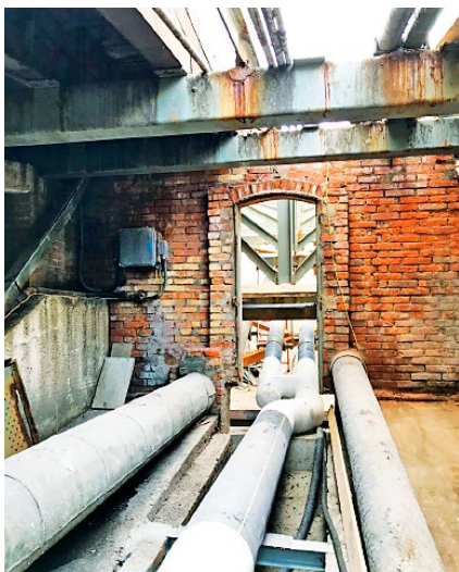
Ryc. 2. Stalowy przewód wodociągowy wytypowany do rehabilitacji
