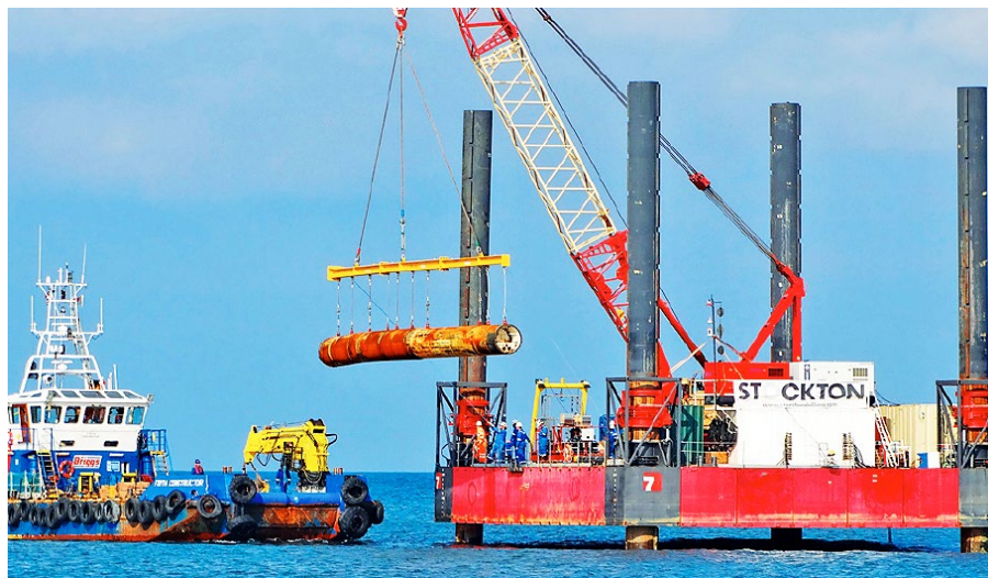
Ryc. 4. Wydobycie głowicy DP-MTBM z dna morskiego
