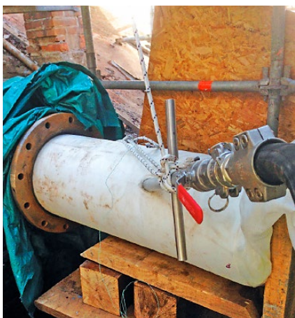
Ryc. 3. Rehabilitacja stalowego przewodu wodociągowego
