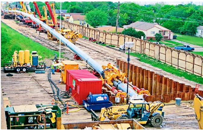
Ryc. 5. Zastosowanie technologii Direct Pipe do wbudowania przewodu wodociągowego w Port Athur w Teksasie
