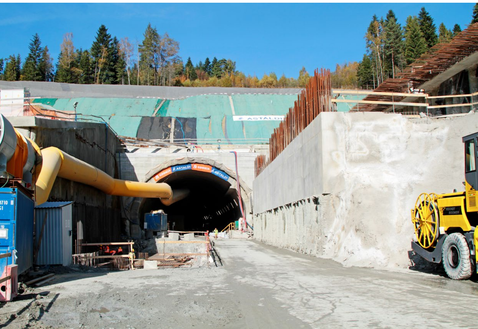
Budowa tunelu na S7 Lubień – Rabka-Zdrój, fot. nbi medla
