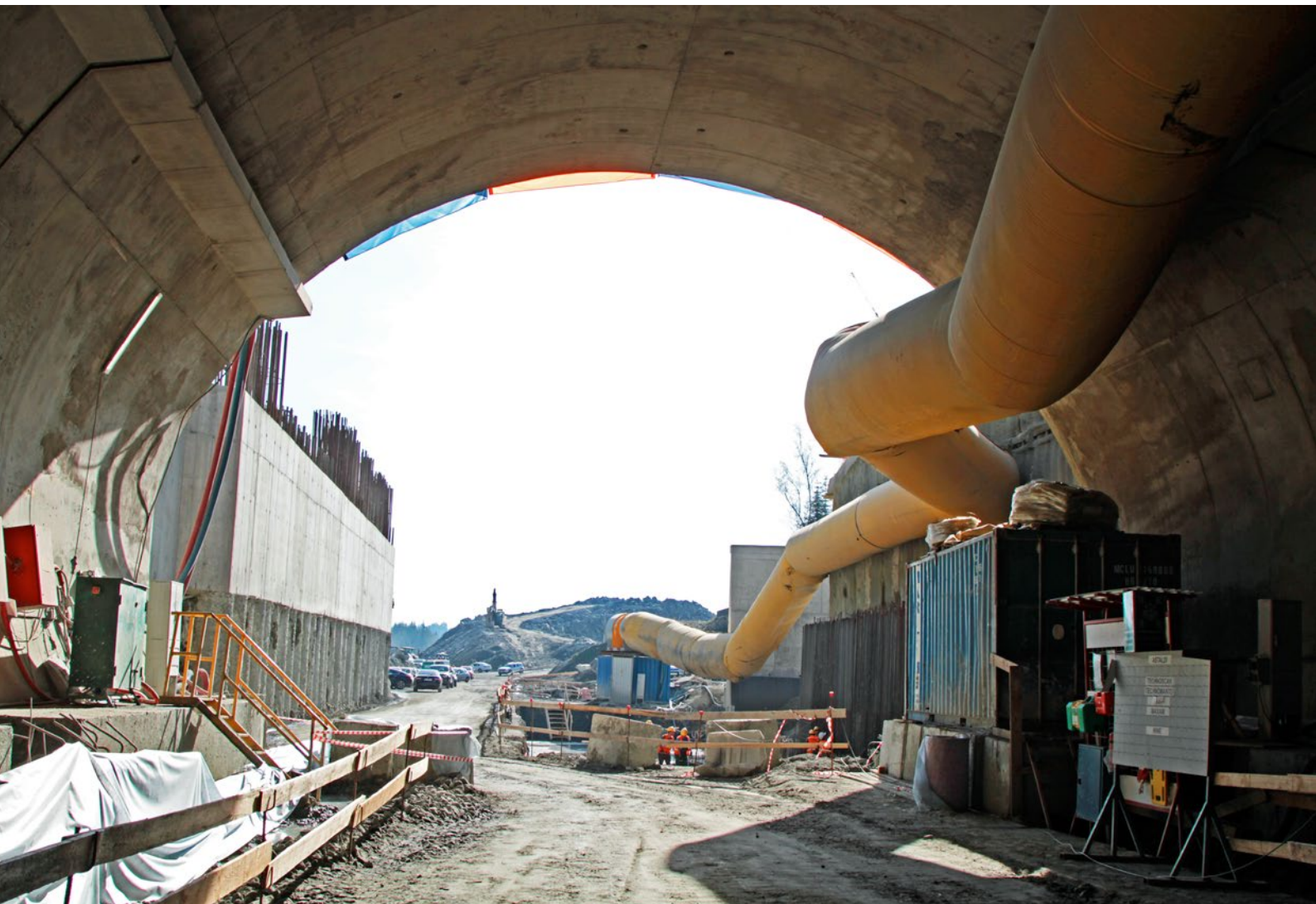
Budowa tunelu na S7 Lubień – Rabka-Zdrój, fot. nbi media
