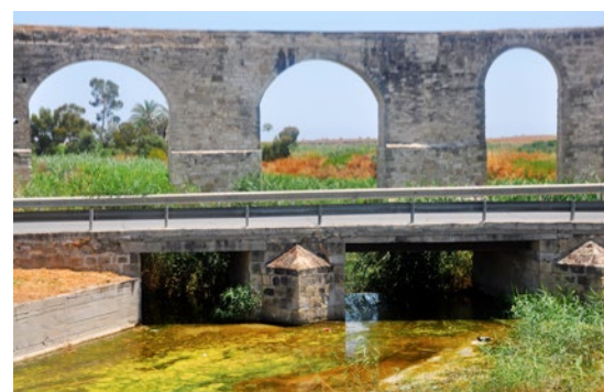
Kamienny akwedukt koło Larnaki (obiekt nr 3) oraz żelbetowy most płytowy koło Larnaki (obiekt nr 4)
