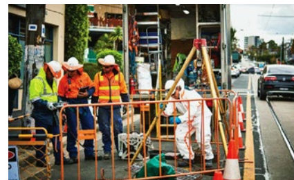
Ryc. 6. Pracownicy firmy Abergeldie podczas rehabilitacji przewodów kanalizacyjnych [1]
