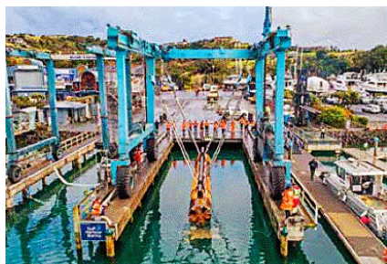
Ryc. 1. Maszyna wykorzystana do wbudowania jednego z odcinków rurociągu [3]
