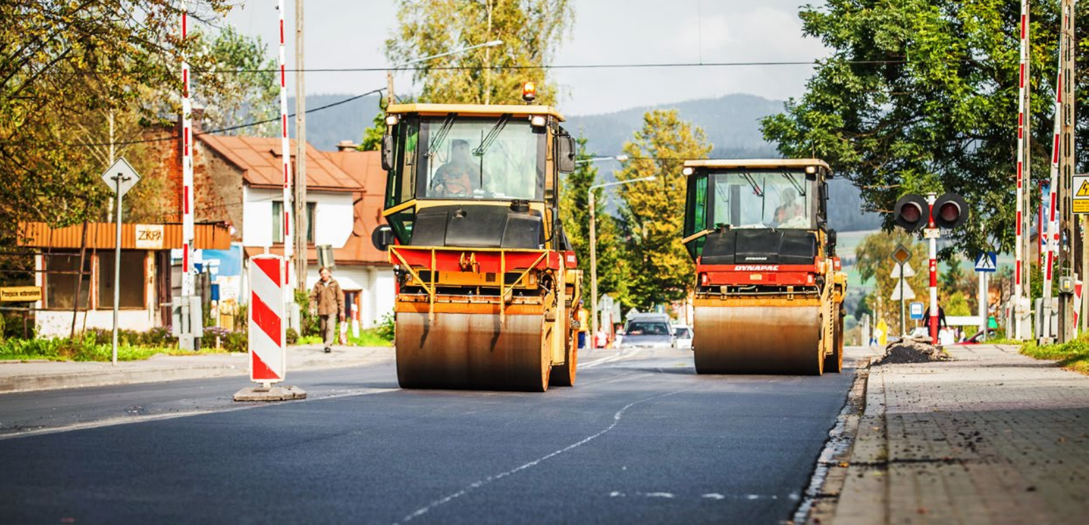
MODBIT – cicha nawierzchnia, przejazd kolejowy w Nowym Targu
