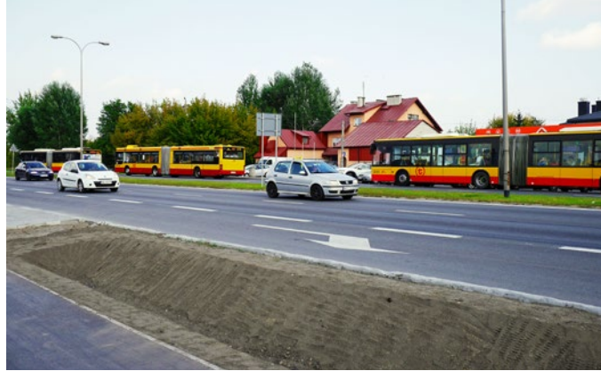
MODBIT HIMA 45/80-80 na nakładkach obciążonych ulic Warszawy
