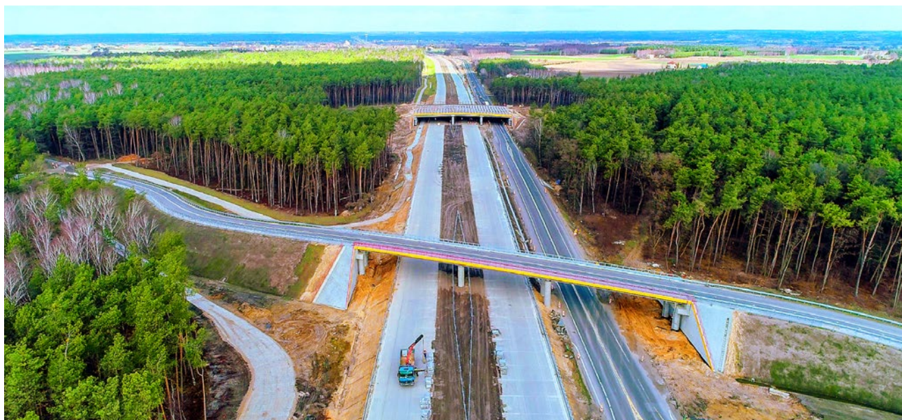
S17, obwodnica Kołbieli, fot. GDDKiA
