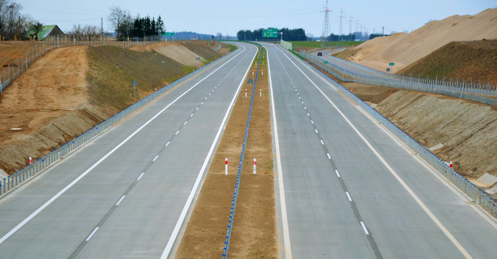
S61, obwodnica Suwałk, fot. SPC
