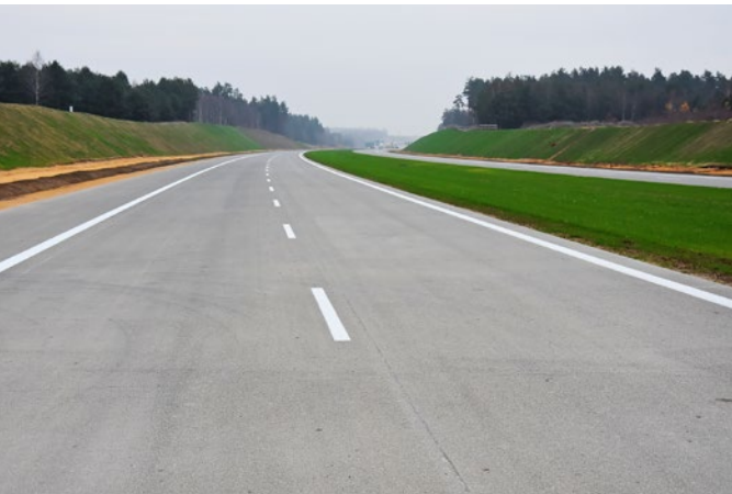
Autostrada A1, obwodnica Częstochowy, fot. SPC
